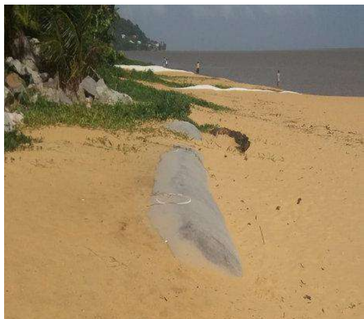
Dispositif Stabiplate à l'Anse Montjoly-Montravel à Rémire-Montjoly (@Mairie Remire-Montjoly)
